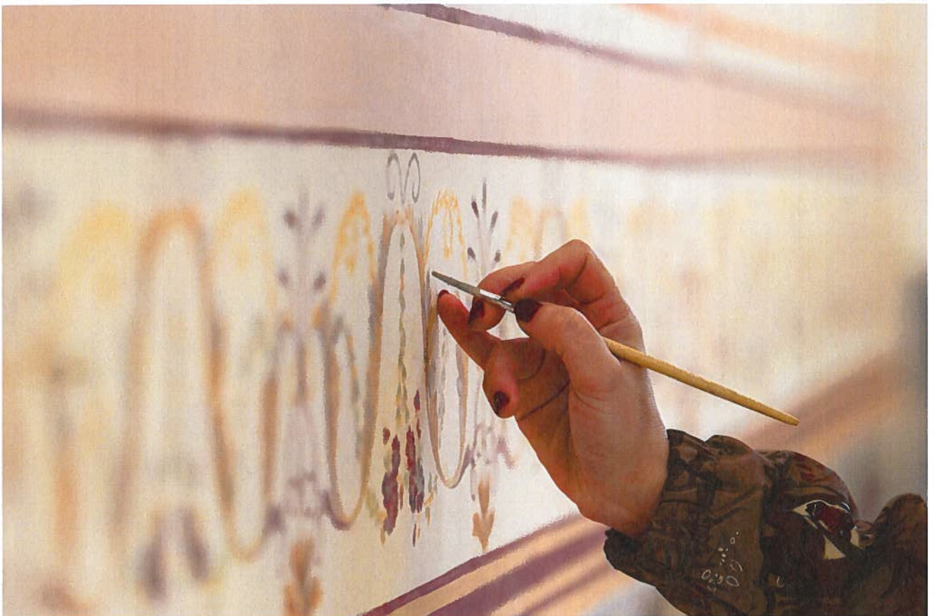
Edifício JBF - Restauro de Frescos | Foto João Peleteiro
