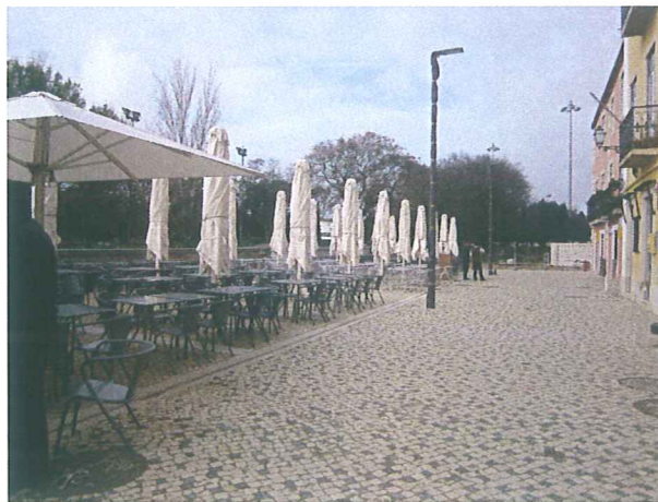
Rua Vieira Portuense – em obra
