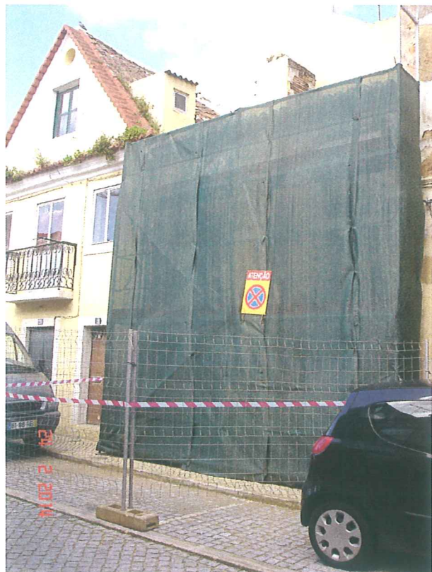
Travessa da Memória, 14-16 – obra
