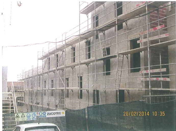
Travessa das Dores – obra
