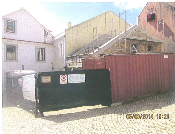
Rua da Correnteza, 19 – obra
