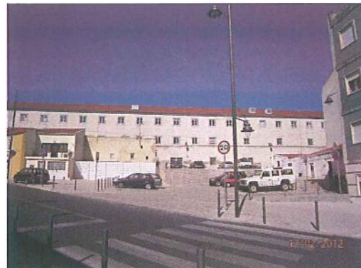
Unidade de Intervenção 10 - depois
