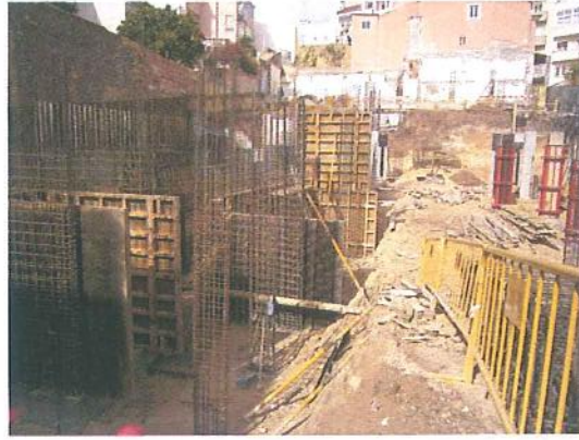
Travessa das Dores – obra
