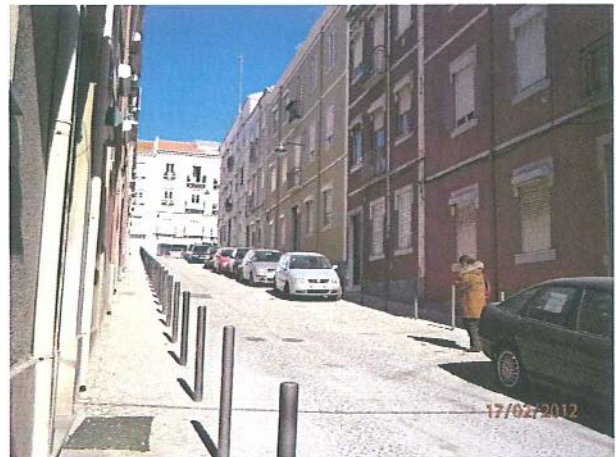
Unidade de Intervenção 6, 7 e 8 - depois
