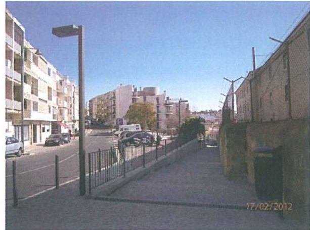
Unidade de Intervenção 10 - depois
