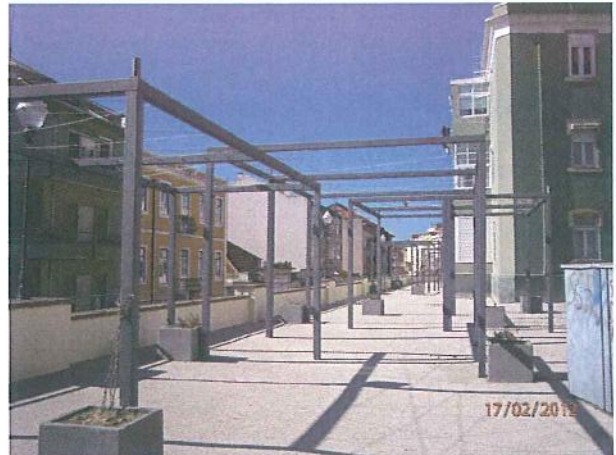
Unidade de Intervenção 6, 7 e 8 - depois
