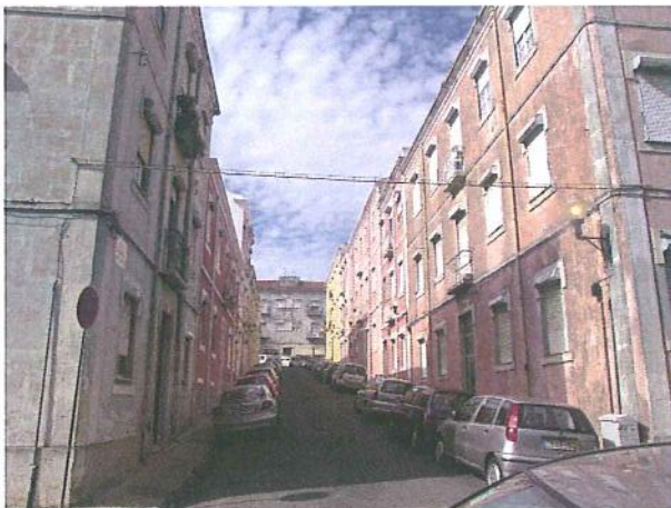
Unidades de Intervenção 6, 7 e 8 – antes
