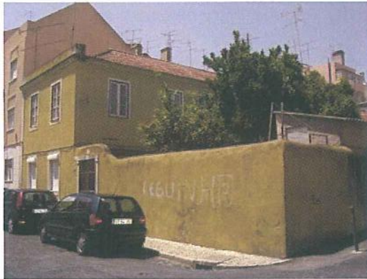
Travessa das Dores – antes
