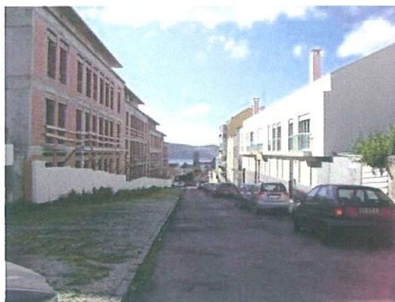
Unidades de Intervenção 1, 2, 4 e 5 – antes
