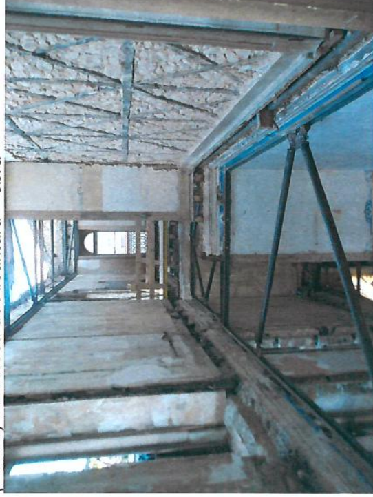
(Futura) Biblioteca de Alcântara – obra
