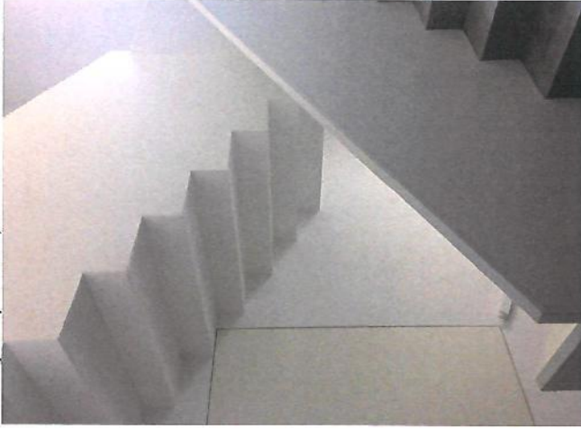
Aliança Operária, 30 – obra concluída
