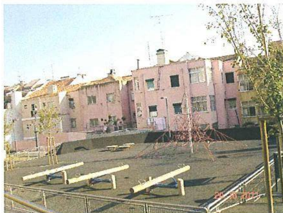
Unidade de Intervenção 9 – obra concluída
