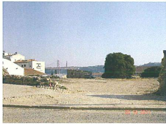
Estacionamento Provisório das Salésias – obra em curso
