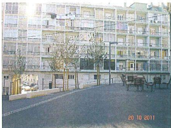
Unidade de Intervenção 9 – obra concluída
