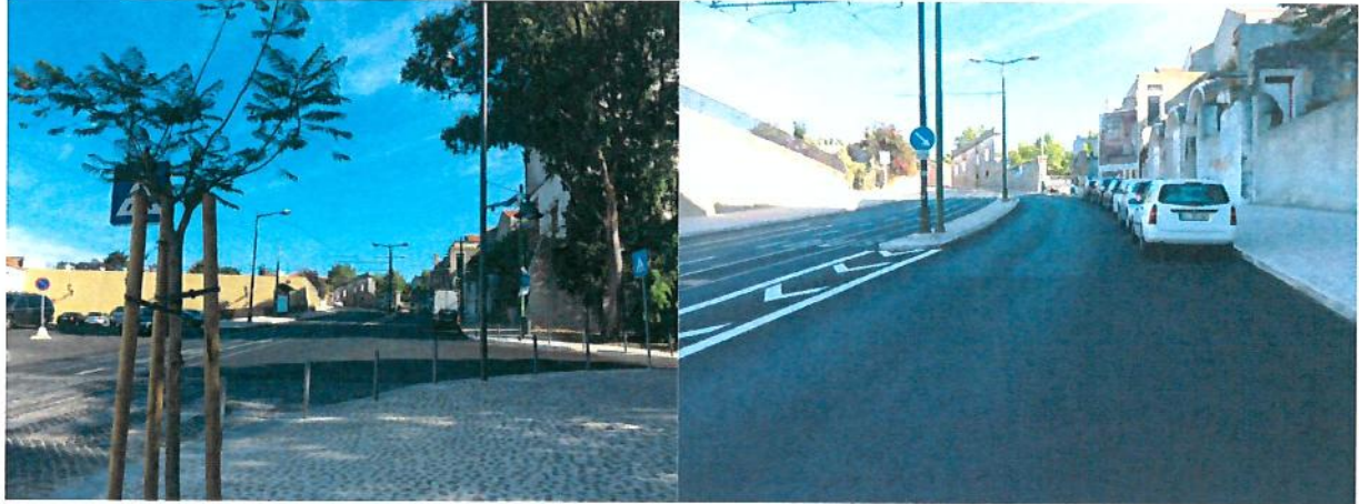
Calçada da Ajuda (continuação) – obra concluída
