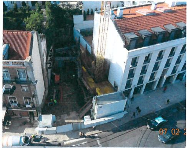
Posto de Socorro Avançado (obra em curso)
