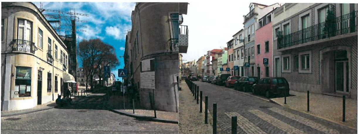
Rua do Embaixador – em obra
