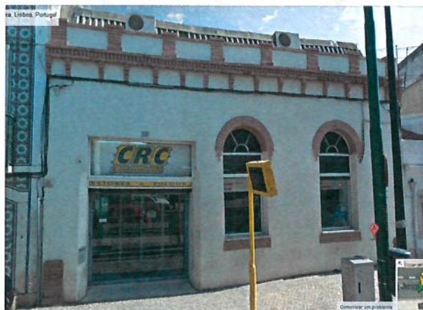
Rua da Junqueira, 243 A (obra concluída)
