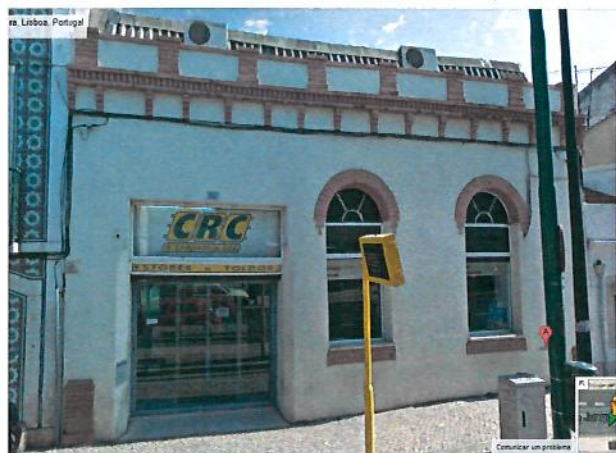
Rua da Junqueira, 243 A (obra concluída)
