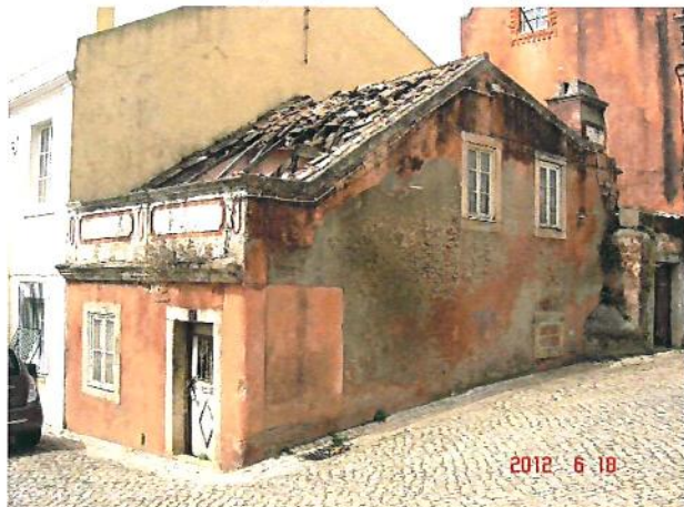
Rua da Correnteza, 21 (antes e depois)
