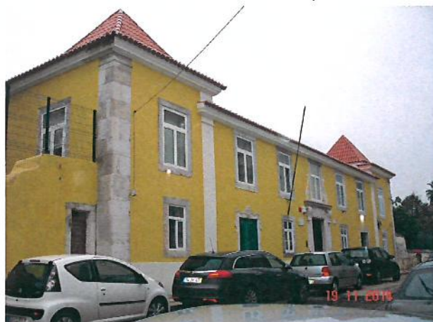
Escola Básica Alexandre Herculano (obra concluída)
