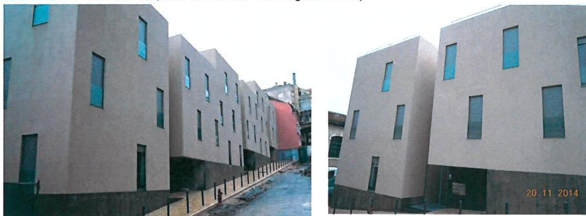
Travessa da Dores, 9-15 (obra concluída e entregue à CML)
