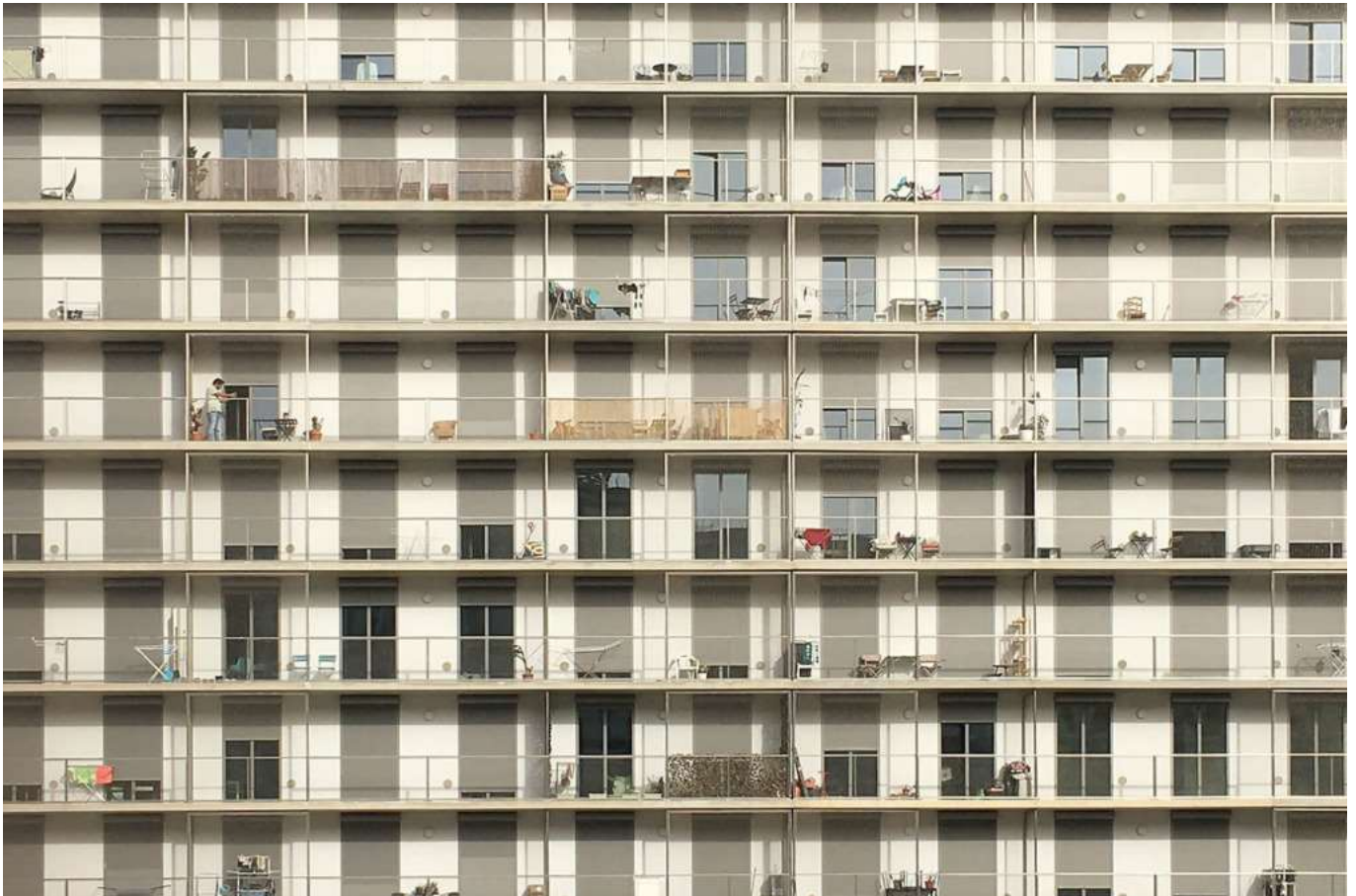
Entrecampos: Edifício-Piloto | Foto Susana Rato
