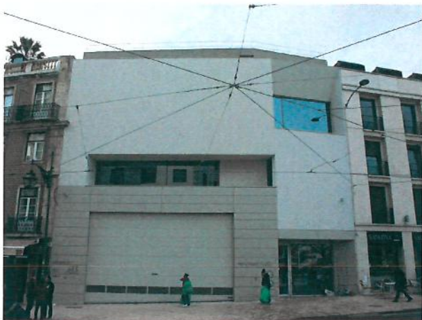
Posto de Socorro Avançado (obra concluída)
