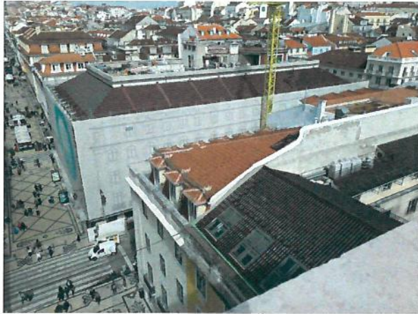
MUDE (obra parada)
