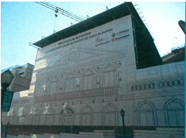
(Futura) Biblioteca de Alcântara (obra em curso)
