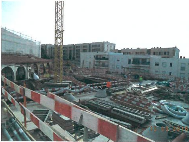
Escola de Caselas (obra em curso)
