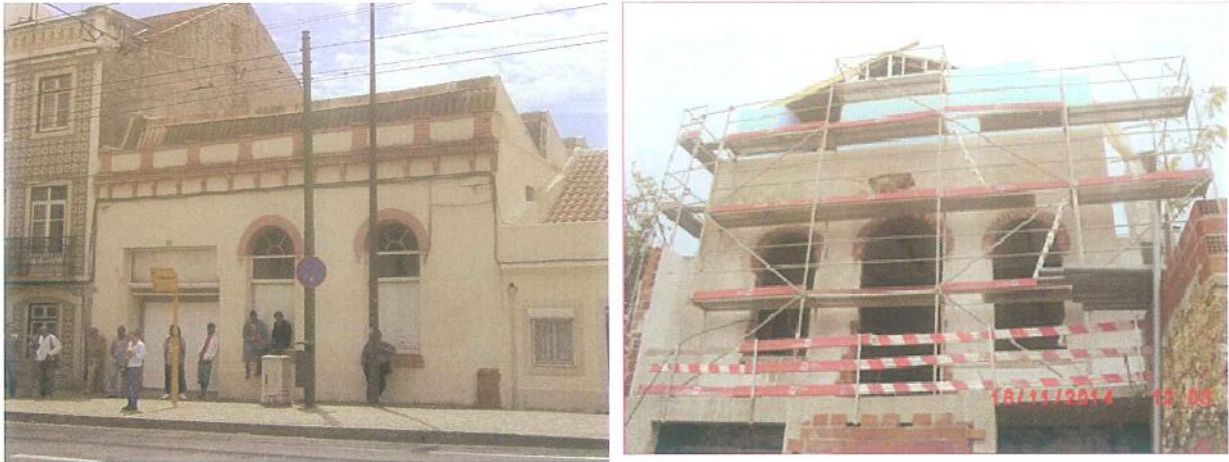
Rua da Junqueira, 243 A (obra em curso)
