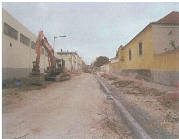
Calçada da Ajuda – obra
