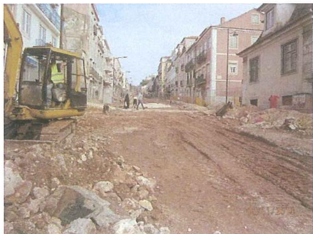
Calçada da Ajuda – obra
