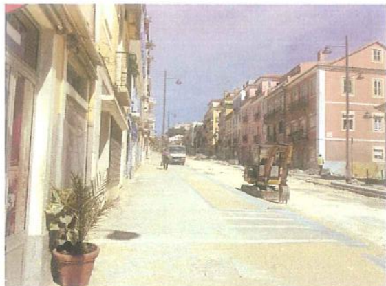
Calçada da Ajuda – obra
